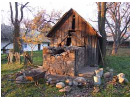
Krupinská planina. Rekonštrukcia chlebovej pece murovanej na vápenno-hlinenú maltu. Projekt viedol Pavel Fabian.
