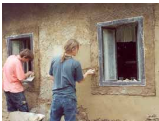
Banská Štiavnica. Rekonštrukcia hlinených omietok fasád baníckeho domu. Projekt viedol Pavel Fabian.
