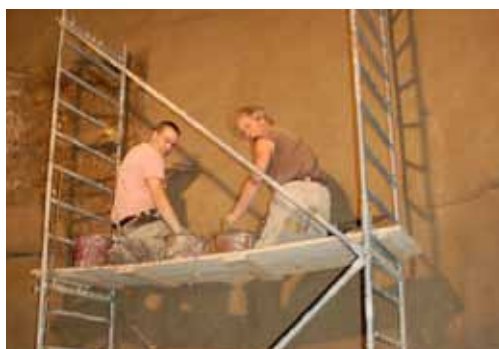
Podpora stavby alternatívneho divadla S2 v Žiline, zo slamených balov omietaných hlinou. „Workshop“ s Tomom Rijvenom
